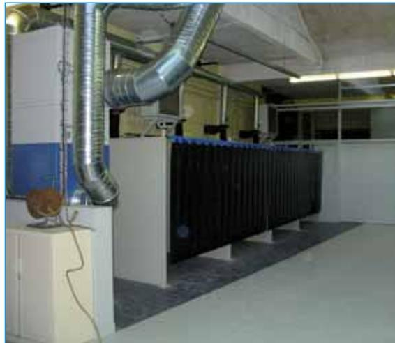
Beispiel für die komplette Installation von mehreren Schweißkabinen, einschließlich Teleskop-Absaugarmen, Verrohrung usw.
